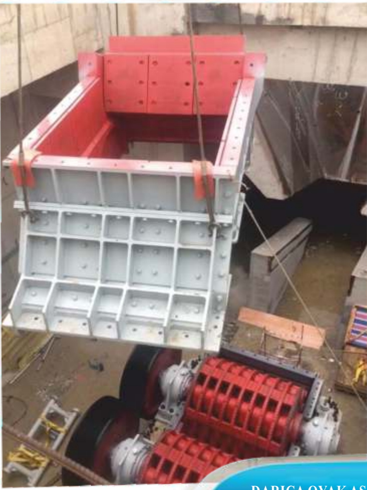
DARICA OYAK ASLAN ÇİMENTO KIRICI VE HAMMADDE TRANSFER HATLARI MONTAJI
