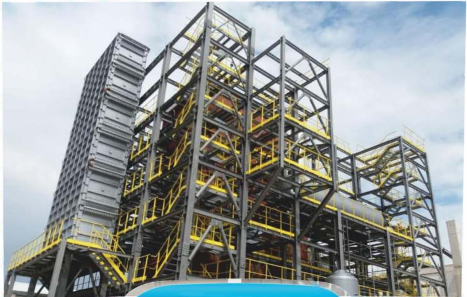
SİNOP SATEM ENERJİ BİYOKÜTLE SANTRALİ ÇELİK KONSTRÜKSİYON İMALAT VE MONTAJI
